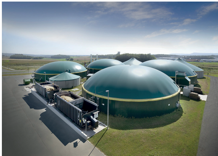
Bioplynová stanice - Brnojebozi.cz
